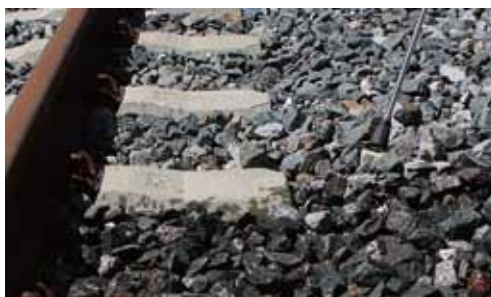
图 4: 沿过渡段的护轨 (左图)，道砟胶粘来稳定道砟的方式 (右图)
