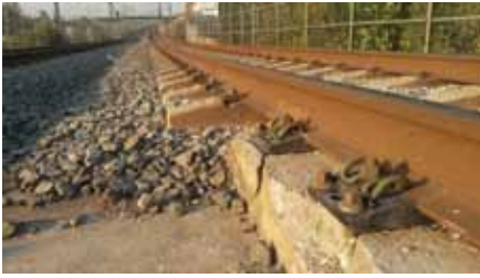
图 2: 有砟轨道到无砟轨道过渡段发生的病害
