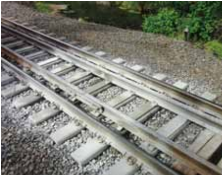
图 2: 有砟轨道到无砟轨道过渡段发生的病害
