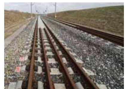
图 4: 沿过渡段的护轨 (左图)，道砟胶粘来稳定道砟的方式 (右图)
